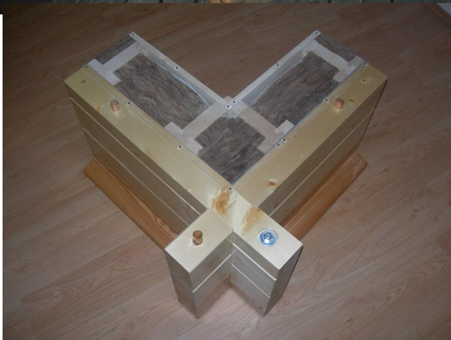
Stenová štruktúra s interiérovou dodatočnou izoláciou
